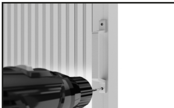
Percez des trous avec une mèche de 4 mm.
