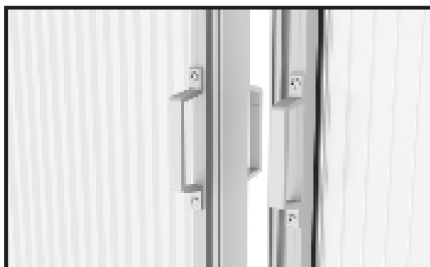
Une fois les poignées de porte intérieures et extérieures fixées, le montage de la porte est terminé.
