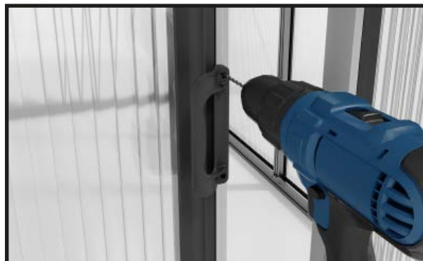
Commencez par les poignées de porte extérieures. Percez des trous avec une mèche de 4 mm.
